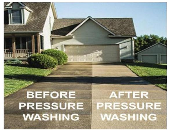
Elimine las manchas y las manchas de aceite con quitamanchas y desengrasantes adecuados. Lave a presión la superficie de concreto para eliminar la suciedad del área a cubrir. Es importante aplicar DRiBOND® sobre una superficie limpia y seca. Asegúrese de dejar que la superficie se seque por completo antes de aplicar DRiBOND.®
