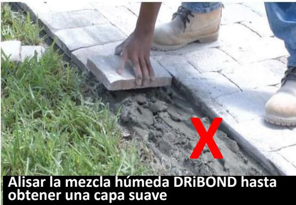
Coloque en húmedo los ladrillos de borde con una llana de muesca de 1/2" con una mezcla húmeda de DRiBOND® para crear un borde de retención de agua. No debe haber bolsas de aire ni vacíos debajo de las baldosas de borde húmedas.
