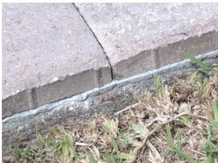
Retire cualquier exceso de producto del borde del área pavimentada terminada. La foto de arriba muestra una instalación adecuada de adoquín de borde.
