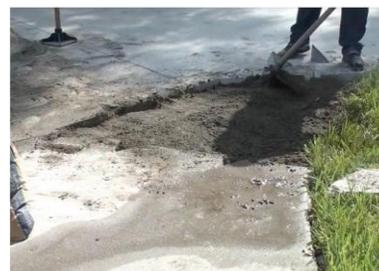
A continuación, rellene el área eliminada con concreto de fraguado rápido de 6,000 psi. Rellene completamente las muescas que se cortaron en el hormigón existente y deje que el hormigón recién colocado se cure.
