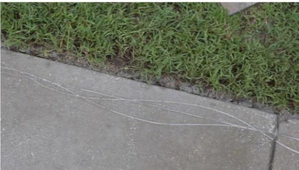
Corte dos o tres ranuras en la losa de concreto existente en el borde. Esto mejora la fuerza de unión cuando se instalan ladrillos de borde.
