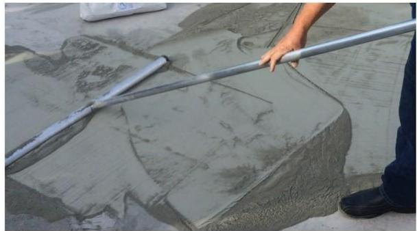
Extienda DRiBOND® con la herramienta de regla de rodillo ST300 con el grosor recomendado de 3/8". Para superficies irregulares o hundimientos, considere aumentar el grosor de la regla a un máximo de 1" para nivelar la superficie. No compacte su regla DRiBOND®.
