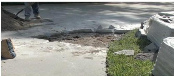
Una vez que se retira el concreto dañado, corte muescas en forma de V en el sustrato de concreto existente con una sierra húmeda y una hoja de diamante. Esto ayudará a vincular el nuevo hormigón con el hormigón existente.
